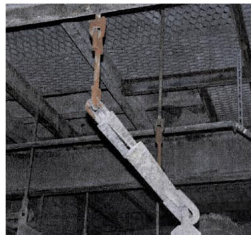
Rys. 12. Zbyt długie cięgno zamocowania
