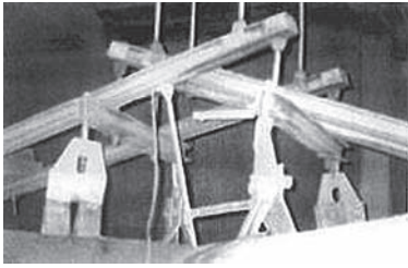
Rys. 3. Wzajemnie poblokowane zamocowania dźwigniowo-ciężarkowe w rejonie czwórników
