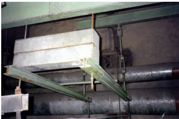
Rys. 6. Zamocowania dźwigniowo-ciężarkowe, konstrukcja według KER
