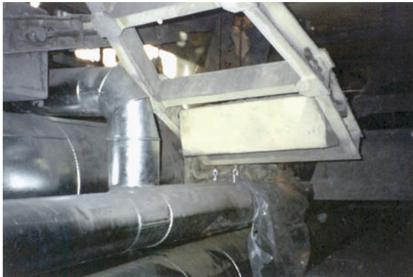
Rys. 5. Zamocowania dźwigniowo-ciężarkowe, konstrukcja stosowana do 1965 roku
