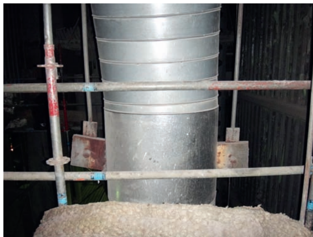
Rys. 4. Obejma zamocowania 10.2S19 – odkształcone ramiona obejmy
