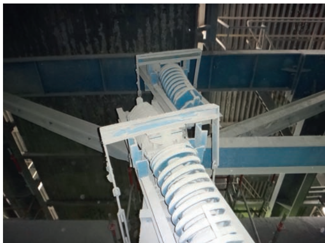
Rys. 2. Zamocowania 10.2G8 oraz 10.1G9 – pochylone belki nośne na skutek zatarcia trzpienia
