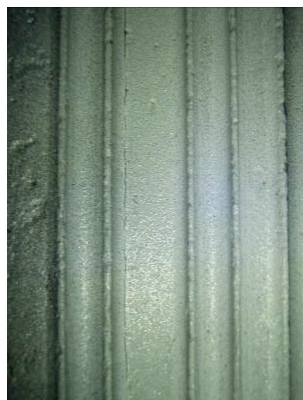
Rys. 21. Pęknięcie wału wirnika turbiny typu 25 MW
