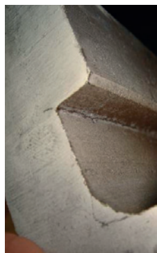
Rys. 25. Pęknięcie w narożu wrębu wału wirnika turbiny typu 120 MW
