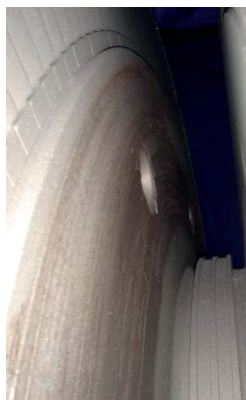
Rys. 20. Przytarcie tarczy wirnika turbiny typu 50 MW
