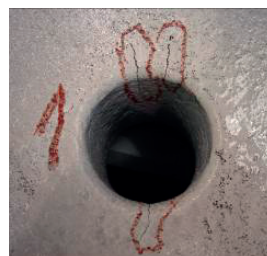
Rys. 18. Pęknięcia tarczy, wirnik turbiny 50 MW
