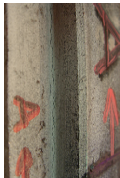
Rys. 24. Pęknięcie w narożu wrębu wału wirnika turbiny typu 120 MW
