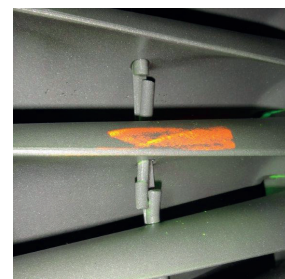
Rys. 9. Pęknięcia drutu łączącego łopatki w pakiety, wirnik turbiny 50 MW
