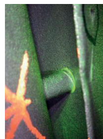
Rys. 8. Pęknięcia drutu łączącego łopatki w pakiety, wirnik turbiny 50 MW
