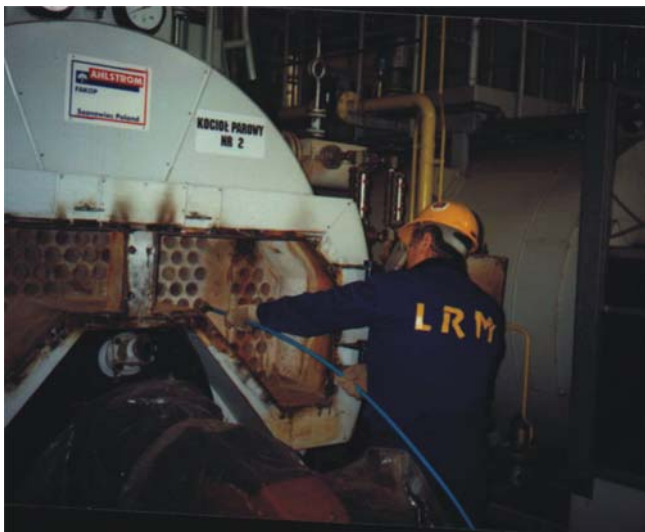
Rys.7. Badania nieniszczące rur stalowych
