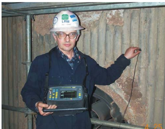
Rys. 2. Pomiary grubości ścianek rur kotłowych sondami LRM-EMAT-PR w Pensylwanii
