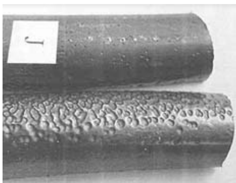
Rys. 7. Erozja – czynnikiem (para grzewcza) na powierzchni zewnętrznej
