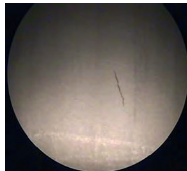
Rys. 5. Wskazanie o dł. 3 mm na powierzchni otworu centralnego wirnika 30 MW
