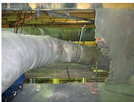
Rys. 20. „Spotkanie” rurociągu ze ścianą
