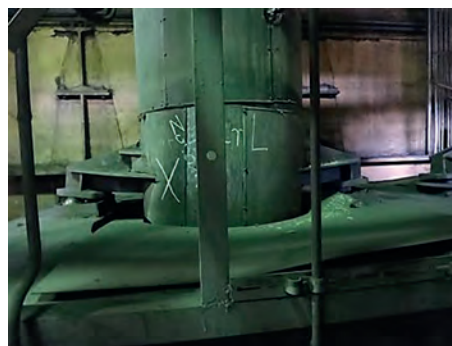
Rys. 15. Ugięcie obejmy podpory stałej
