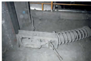
Rys. 10. Całkowicie zerwane obie części ciężna zamocowania stałositolowego Z5 prawej nitki rurociągu pary do wtórnego przegrzewu. W tym przypadku słupy kotłowni nie były „naturalnym” ogranicznikiem amplitudy drgań gasnących wywołanych uderzeniem hydraulicznym
