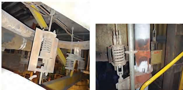
Rys. 6. Pozostawienie blokad zamocowań sprężynowych (poziomych i pionowych) na czas próby wodnej
