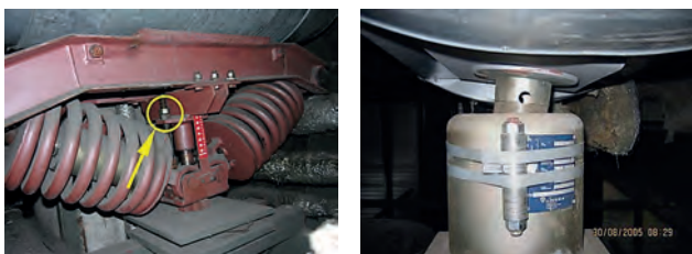
Rys. 7. Pozostawienie fabrycznych blokad zamocowań
