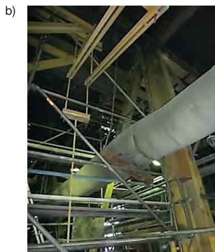
Rys. 16. Zmiana trasy i wykrzywienie zawieszenia poziomego odcinka rurociągu
