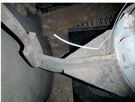
Rys. 13. Wygięta obejma zawieszenia 6P, przesunięta prawa nitka rurociągu w kierunku rurociągu pary wtórnie przegrzanej
