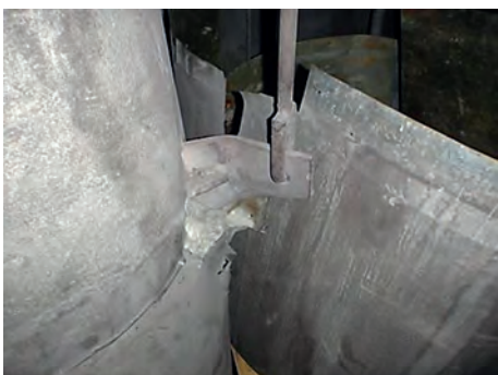
Rys. 14. Wygięta obejma zamocowania 6L i przesunięcie lewej nitki rurociągu w kierunku rurociągu pary wtórnie przegrzanej
