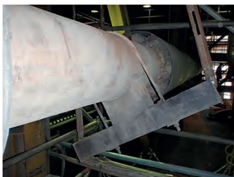
Rys. 11. Znaczące przesunięcie rurociągu na zewnątrz od bocznej ściany kotła – istotne skrzywienie zamocowania 32P
