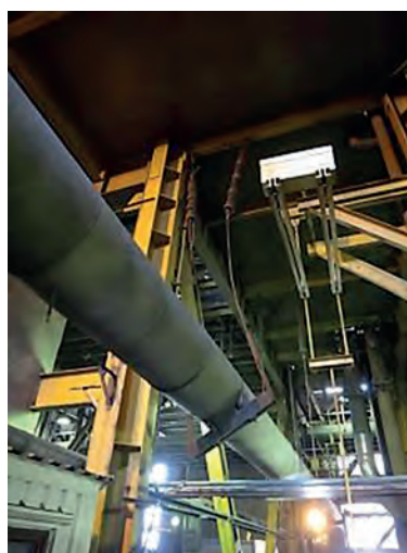
Rys. 16. Zmiana trasy i wykrzywienie zawieszenia poziomego odcinka rurociągu
