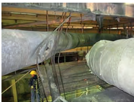
Rys. 21. „Spotkanie” rurociągu z rurociągiem pary świeżej
