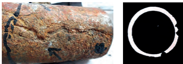
Rys. 6. Uszkodzenia korozyjne rury ekranowej
