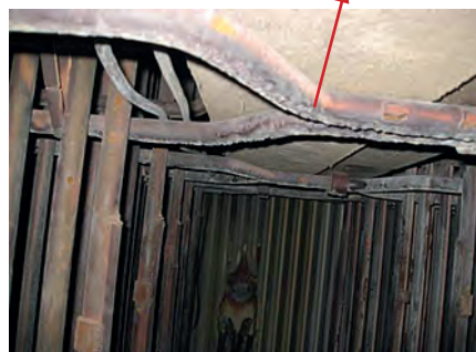
Rys. 15. Ubytek erozyjny ścianki rury
