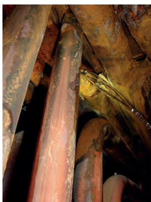
Rys. 10. Perforacja węzownicy przegrzewacza w miejscu przejścia przez strop
