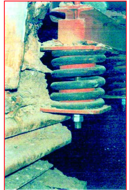
Rys. 11. Kolizja stojaka jednosprężynowego zawieszenia poziomego z kanałem powietrznym
