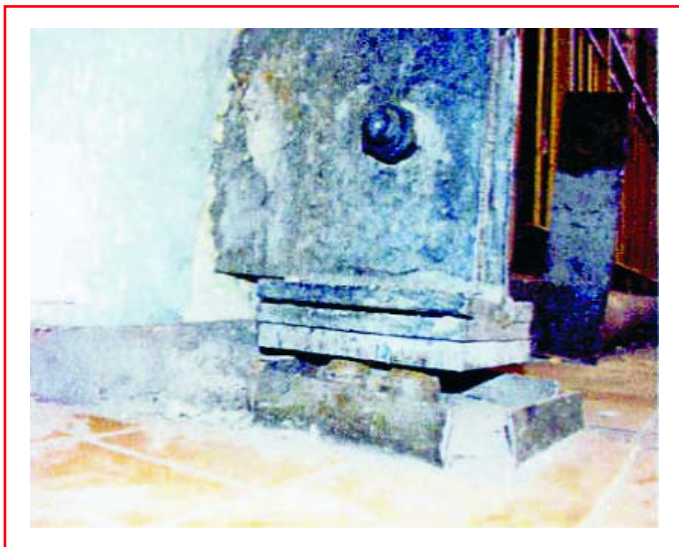
Rys. 5. Zbyt mała jezdnia podpory kulowej pionowej
