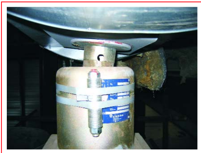
Rys. 14. Pozostawiona blokada na czas próby wodnej – skrzywiony stół sprężynowy
