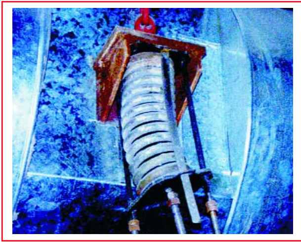
Rys. 19. Wyboczona sprężyna zamocowania dwukolumnowego sprężynowego poziomego
