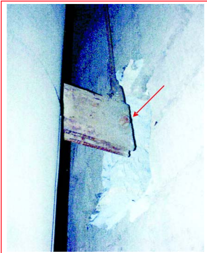
Rys. 10. Kolizja obejmmy zamocowania dwukolumnowego, pionowego i ściany kotłowni
