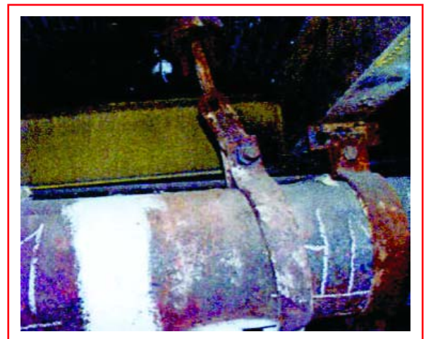
Rys. 13. Pozostawiona blokada montażowa, „wyłączone” z pracy zawieszenie sprężynowe
