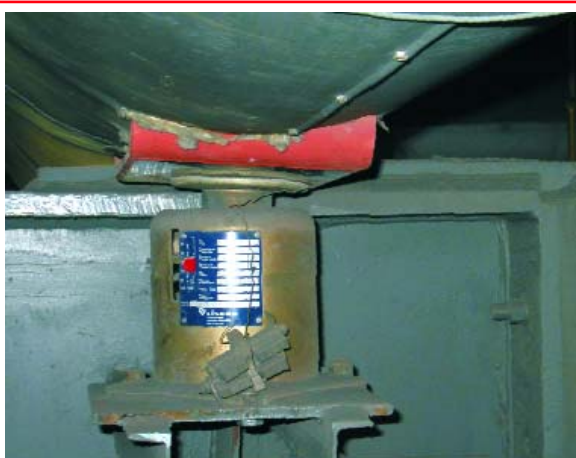
Rys. 16. „Sklejone teflonem” powierzchnie ślizgowe stołów sprężynowych doprowadziły do wykrzywienia zamocowania
