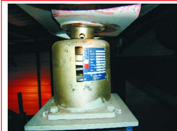
Rys. 16. „Sklejone teflonem” powierzchnie ślizgowe stołów sprężynowych doprowadziły do wykrzywienia zamocowania
