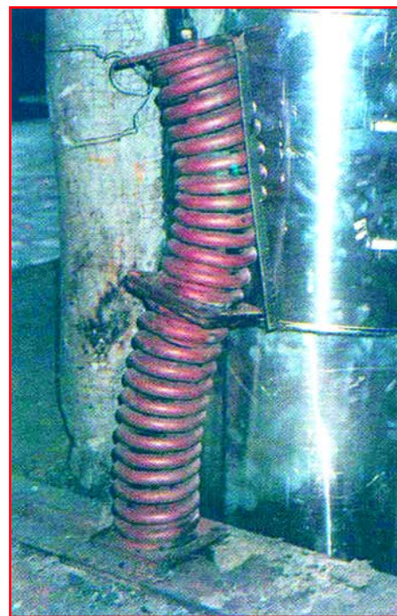
Rys. 2. Przykład zastosowania zamocowania o zbyt małej nośności. Przeciążony stojak sprężynowy – wyboczona i zgnieciona sprężyna
