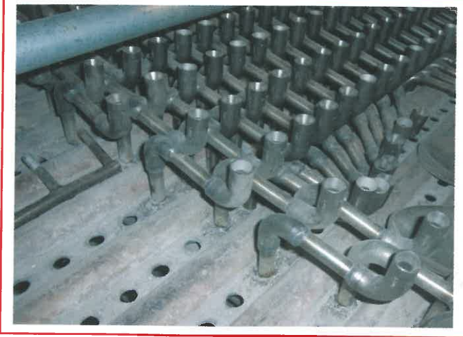
Rys. 7. Dysze powietrza pierwotnego
