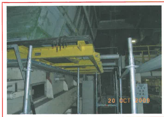
Rys. 6. Zastąpienie ręcznych zasuw prętowych pod zasobnikami węgla na zautomatyzowane sterowane hydraulicznie (szpilek)
