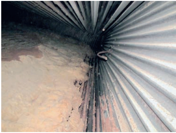
Rys. 7 Szlakowanie rur ekranowych jako rezultat spalania biomasy oraz pracy kotła z licznymi uruchomieniami i obniżonym minimum technicznym
