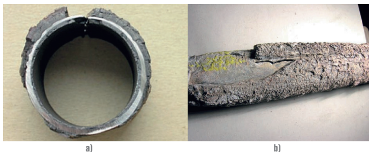
Rys. 2 Zakończenia cyrkulacji czynnika w kotle – korozja wysokotemperaturowa – obustronne pocienienie ścianki węzownicy aż do perforacji: a) przekrój poprzeczny, b) powierzchnia zewnętrzna. Źródło: opracowanie własne
