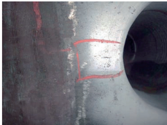
Rys. 4 Pęknięcia na krawędzi otworu pod rurę opadową w strefie wodnej walczaka. Źródło: opracowanie własne
