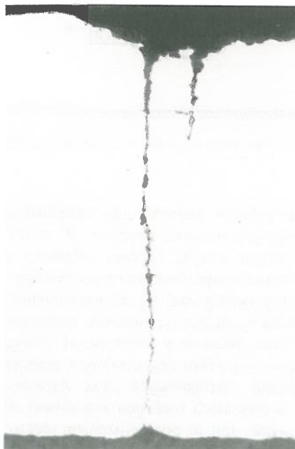
Rys. 4. Śródkrystaliczny charakter pęknięcia
