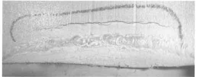
Rys. 3. Kolan segmentowe, pęknięcie w okolicy spoiny czołowej Fig. 3. Knee segment, rupture near to a butt weld
