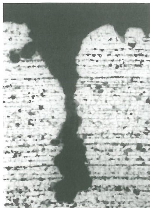
Rys. 3. Charakter pęknięcia biorącego początek na krawędzi, widoczne liczne wżery na powierzchni wewnętrznej walczaka
