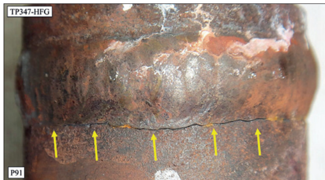
Rys. 1. Pęknięcie w SWC spoiny po stronie materiału P91
