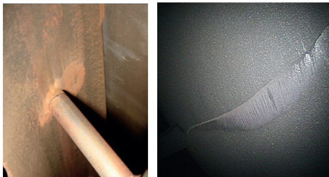
Rys. 6. Wyniki badań endoskopowych wykonanych w ramach nadzoru diagnostycznego
