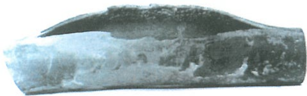
Rys. 8. Uszkodzenie wywołane kruchością wodorową, pęknięcie wzdłużne z nieznacznym rozwarciem
