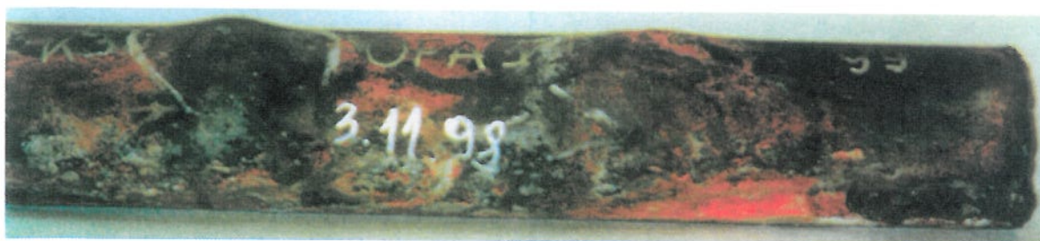
Rys. 3. Uszkodzenie rury wywołane wytrącaniem się osadów na powierzchni wewnętrznej
