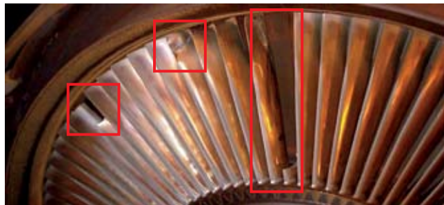
Rys. 2. Urwane i zdeformowane łopatki części niskoprężnej turbiny
