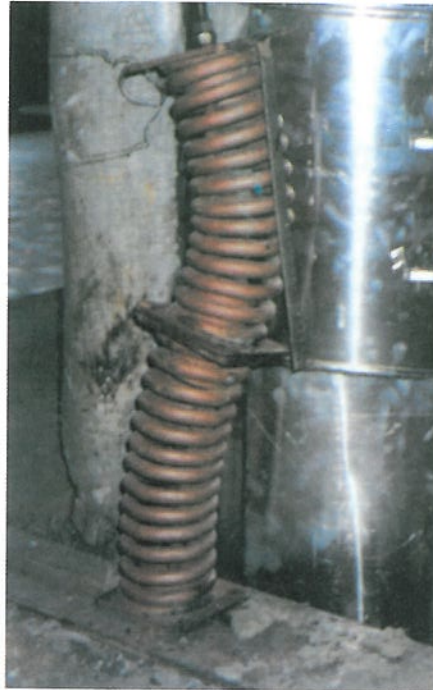
Rys. 2. Wyboczona kolumna sprężyny; zamocowania o niewłaściwie dobranej reakcji
