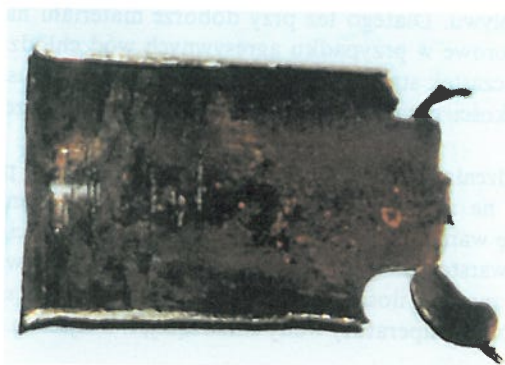
Rys. 1. Typowe uszkodzenie erozyjne wlotów rurek miedzianych
